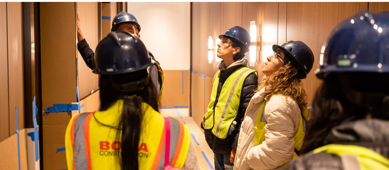
HIRE360 participants tour a construction site
